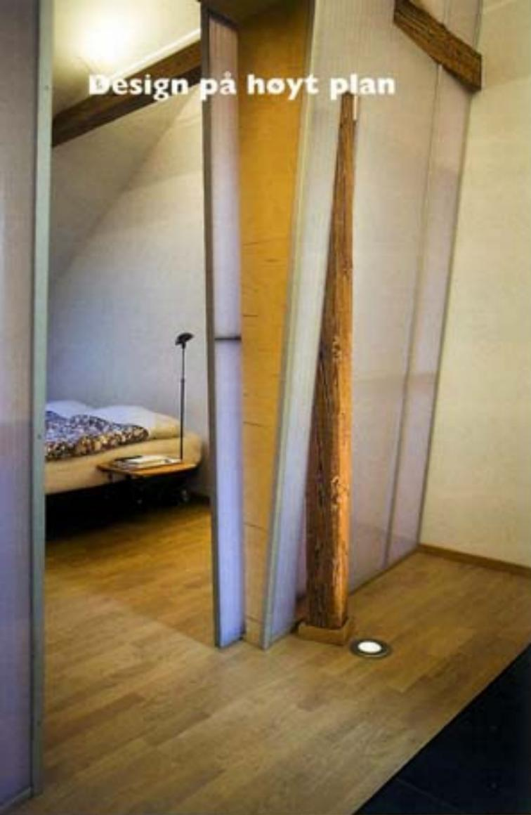
Den gjennomskinnelige veggen er lagd av 25 mm tykke plater av polykarbonat, også kalt kanalplast. Fordi veggen/hyllen står mot skjeve vegger og tak, måtte veggen bestå av et vell av tredimensjonalt tegnede kryssfinerelementer. Om kvelden lyser dette rommet som en kinesisk lykt.
