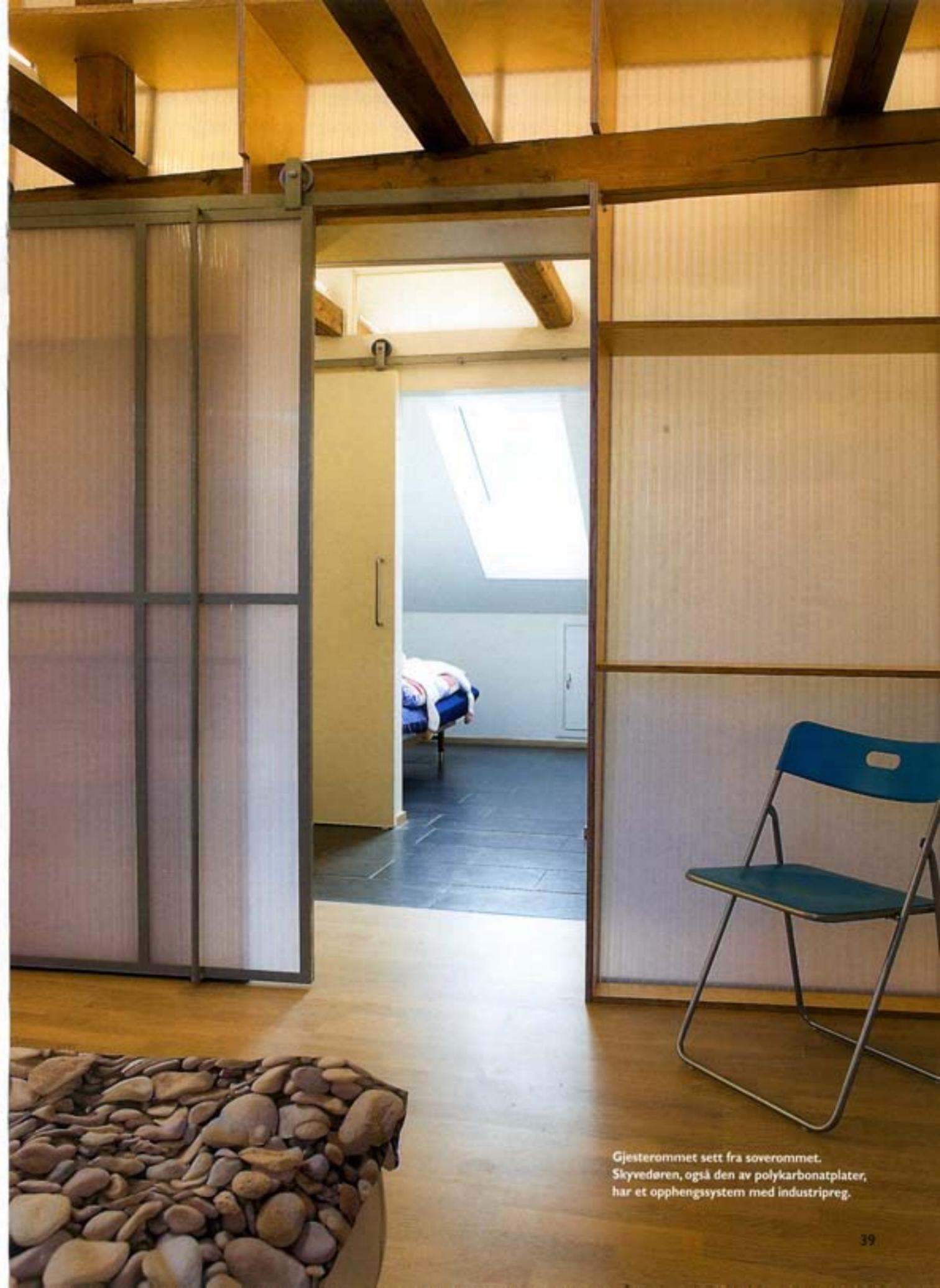
Gjesterommet sett fra soverommet. Skyvedøren, også den av polykarbonatplater, har et opphengssystem med industripreg.
